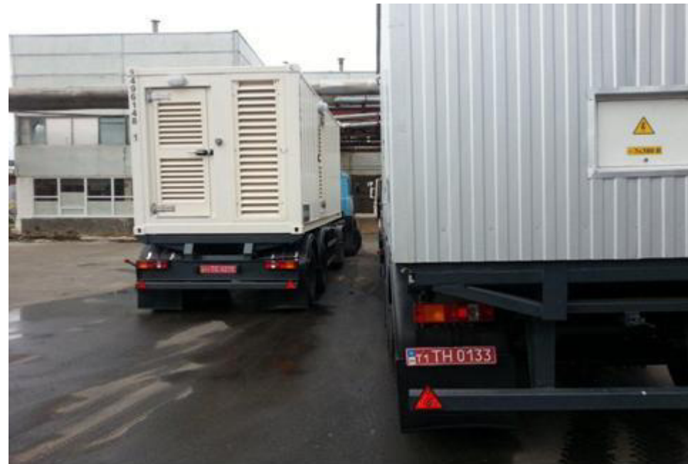
0.4 kV/800 kW mobile DGs
